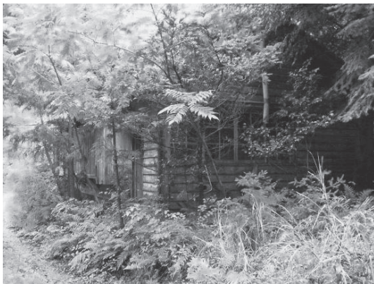
写真3 営林署の旧造林合宿所
