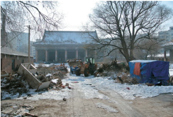
氷点下17℃の朝もやの中に建つ旧建国忠霊廟 回廊内の現在の様子。奥に見える大きな建物が旧祭殿である。重機による瓦礫の撤去作業の最中であった。
