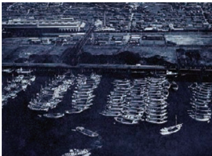
写真 68 岸壁に待機する機帆船 （藤ノ木栈橋）（通番 69）
