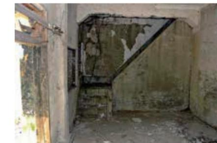
写真2 新化社地下神殿の内部。正面の階段は元の社務所につながる。一方、左側は崖に口を開いた開口部である。壁・天井を仕上げていた漆喰はほとんど剥落しているが、壁・天井境の入隅を回線代わりに装飾的に塗り廻したコブなどに一部漆喰が残っている。
