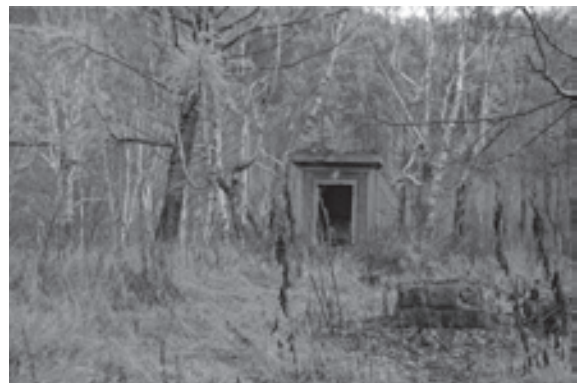
写真5 旧 みすもと 恵須取町の太平国民学校の奉安殿 2013年撮影 ※監修者注＝恵須取町太平には国民学校は太平第一国民学校と太平第二国民学校があったが、写真の奉安殿は、いずれかは不明。恵須取＝ウグレゴルスク
