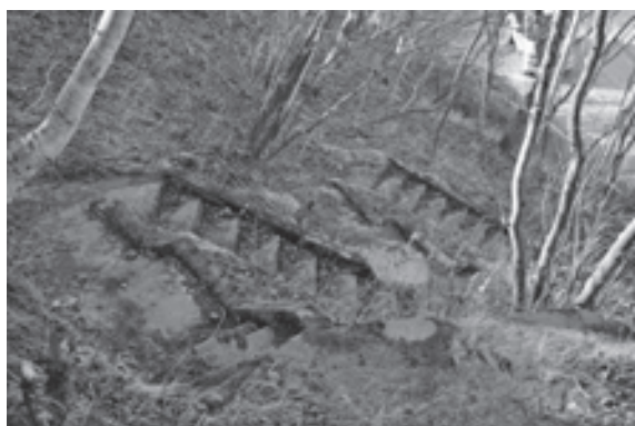
写真 30 水天宮 コンクリートの階段
