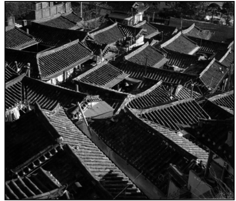
▷嘉会洞一帯の都市韓屋住宅地の全景 (『韓国現代住居学』1990)
